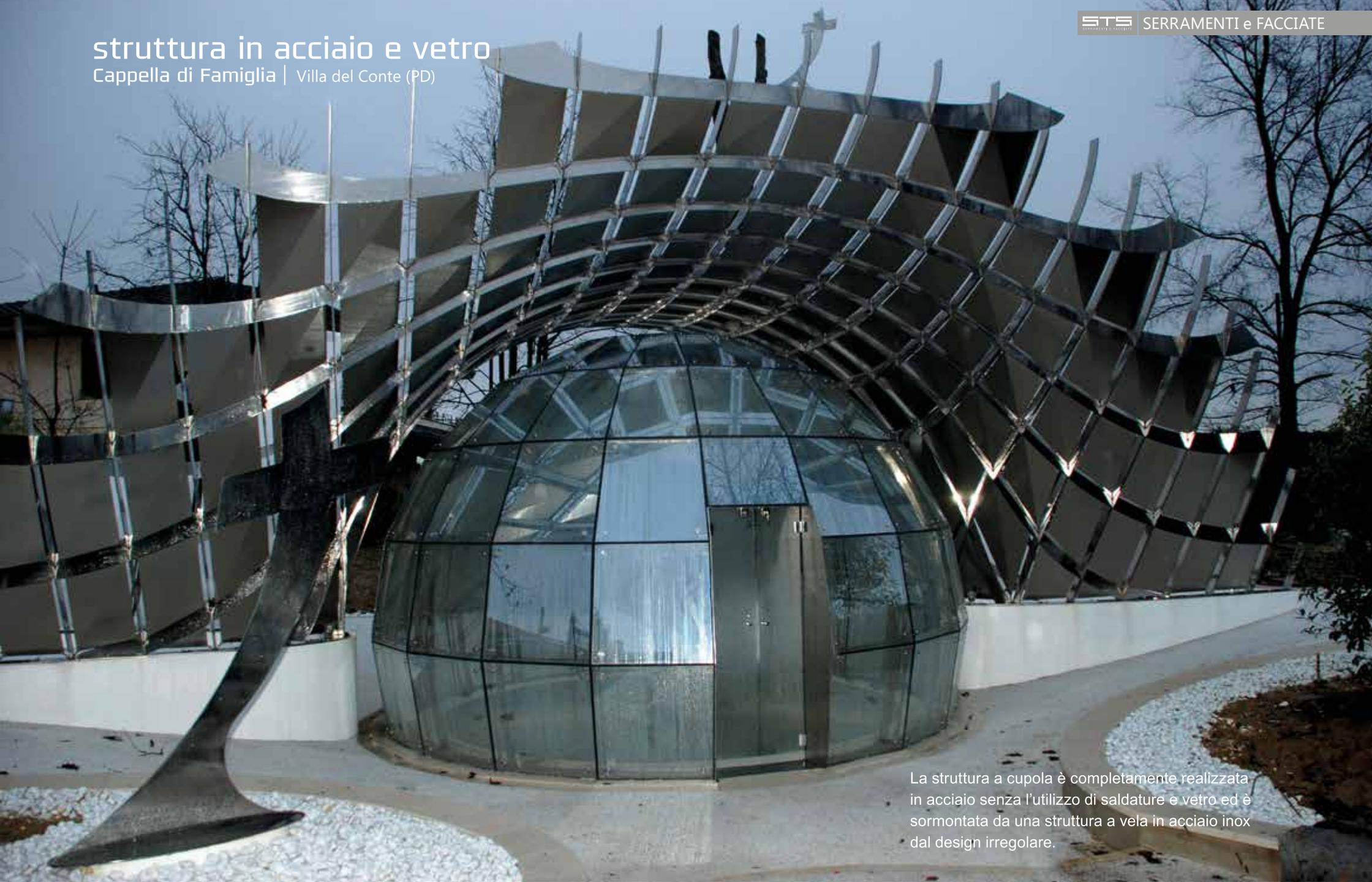
La struttura a cupola è completamente realizzata in acciaio senza l'utilizzo di saldature e vetro ed è sormontata da una struttura a vela in acciaio inox dal design irregolare.
